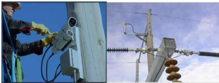
Рис. 3. Видеокамеры и тензодатчики
