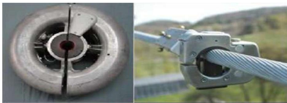
Рис. 2. Мониторы температуры проводников с радиосвязью
